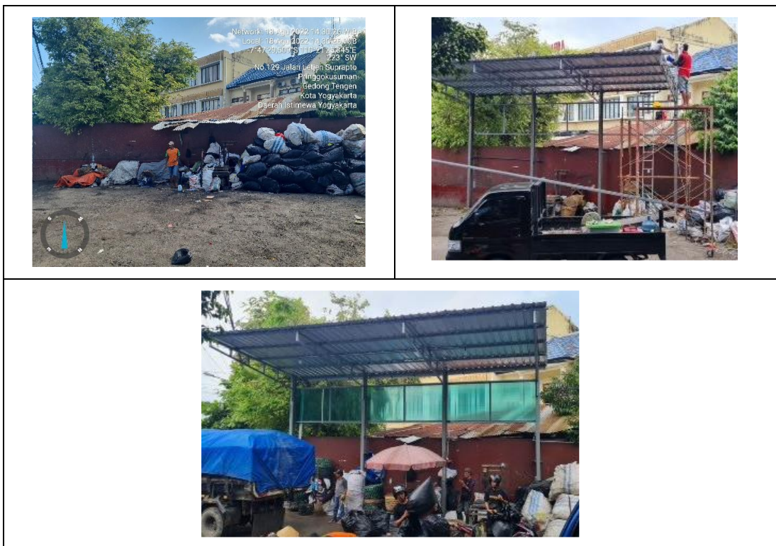
Gambar 3. 20 Kegiatan Pelaksanaan Pekerjaan Rehabilitasi Depo/TPS Pringgokusuman
