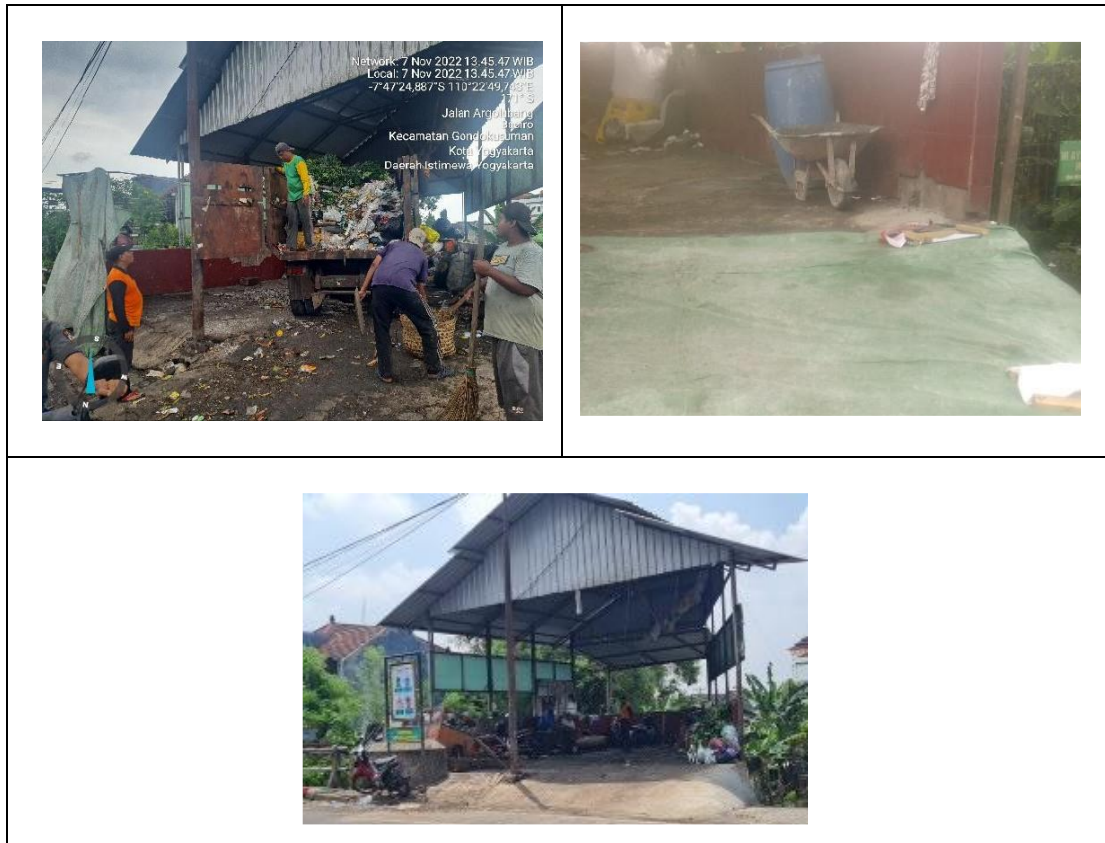
Gambar 3. 17 Kegiatan Pelaksanaan Pekerjaan Rehabilitasi Depo/TPS Argolobang
