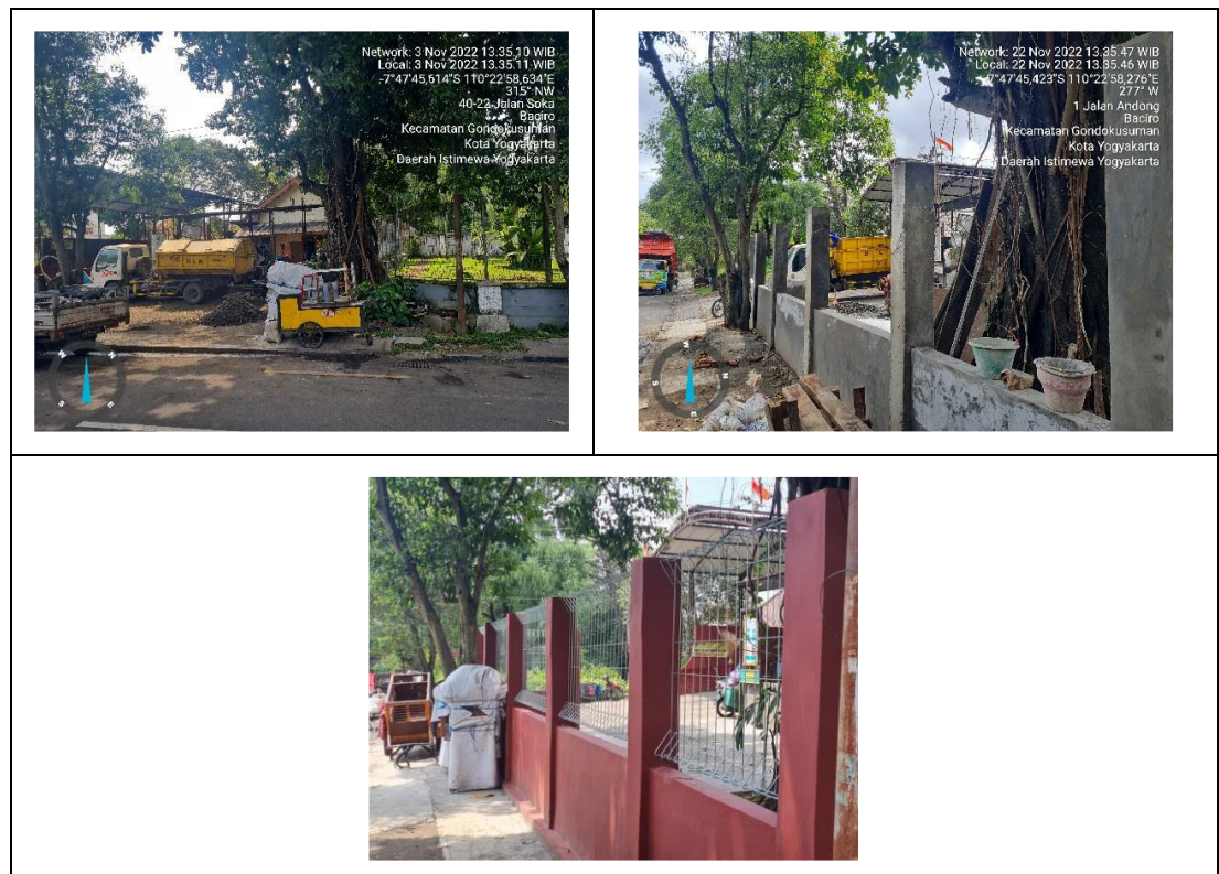
Gambar 3. 18 Kegiatan Pelaksanaan Pekerjaan Rehabilitasi Depo/TPS Mandalakrida
